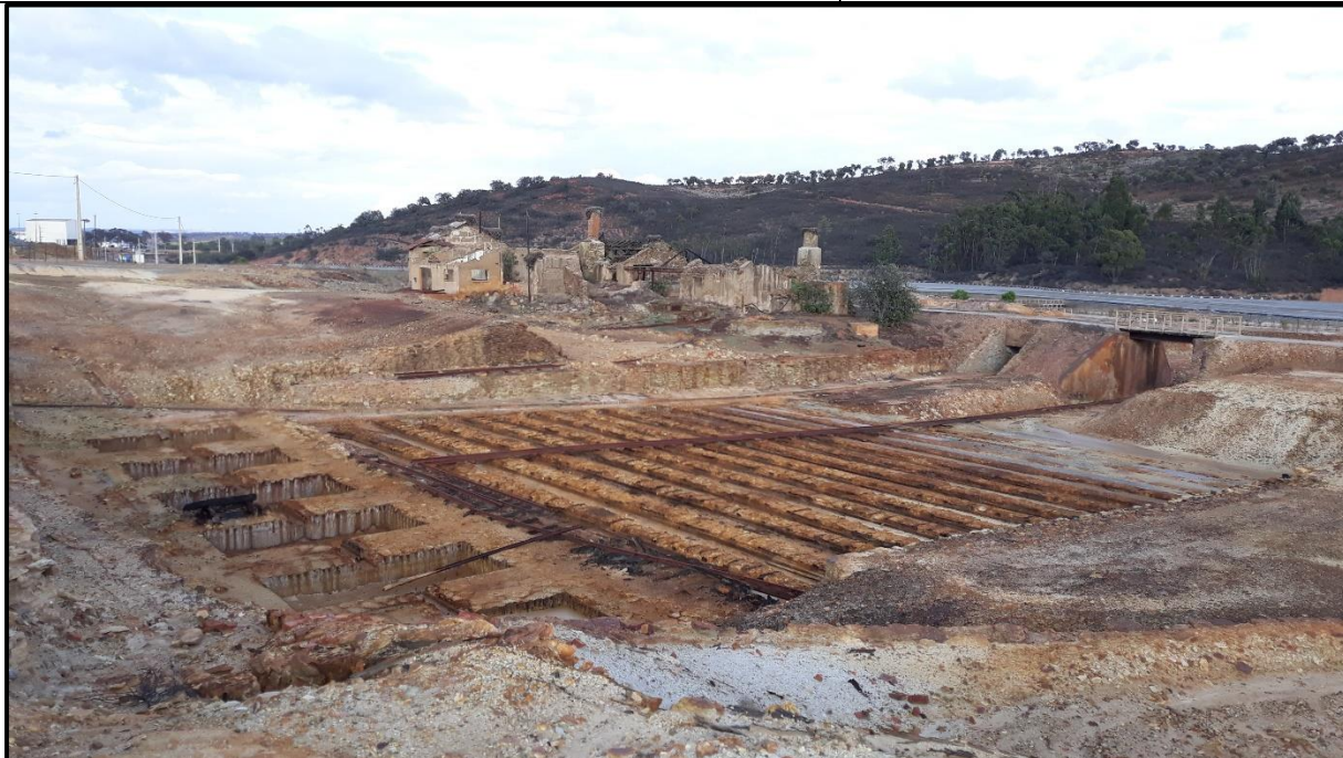
Vista geral da cementação de Algaes
