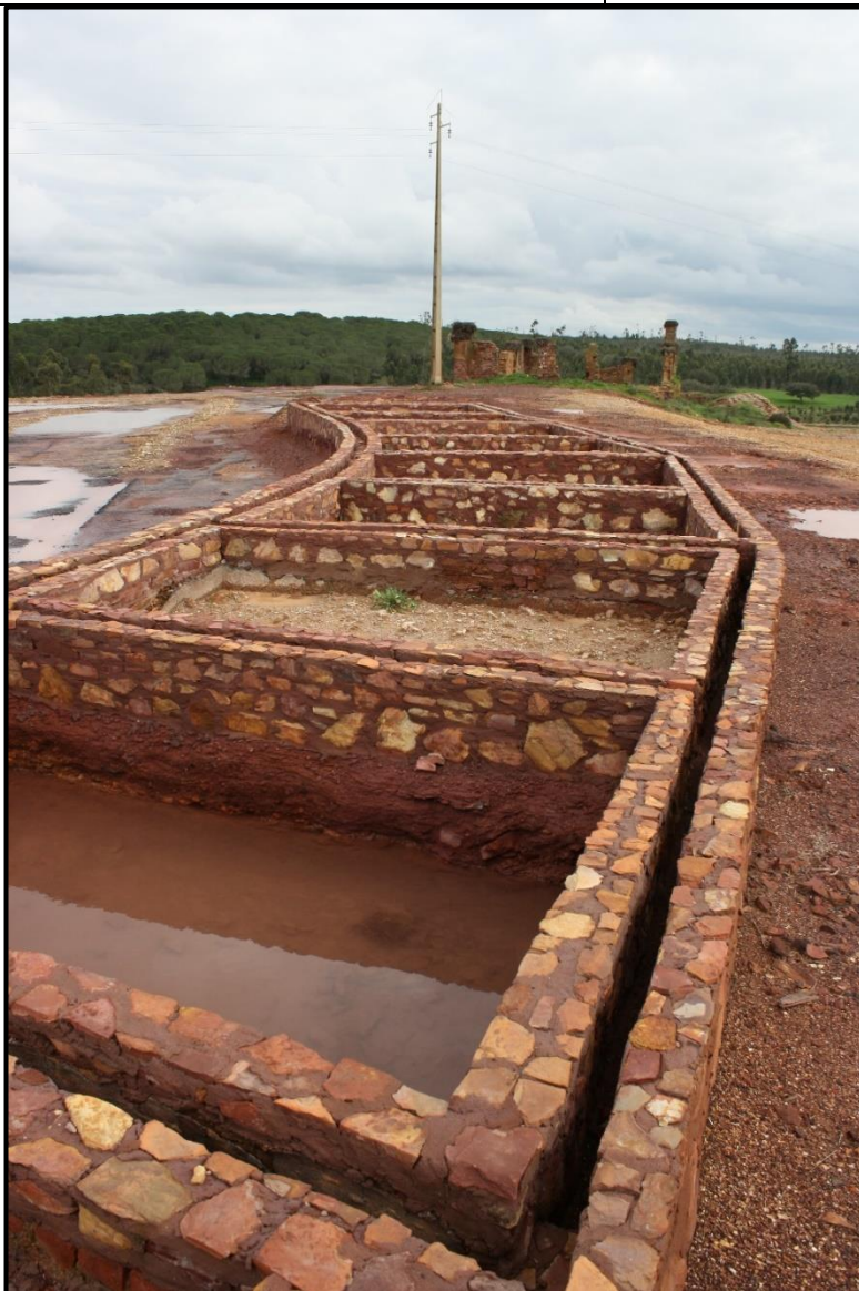
Tanques de Cementação
